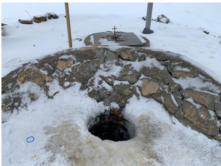
**Рисунок 2. Каптажное устройство и выход воды**
