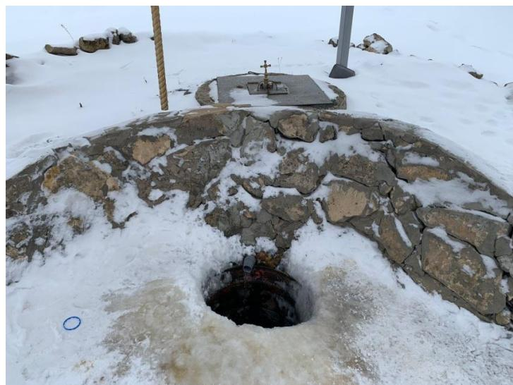
**Рисунок 2. Каптажное устройство и выход воды**
