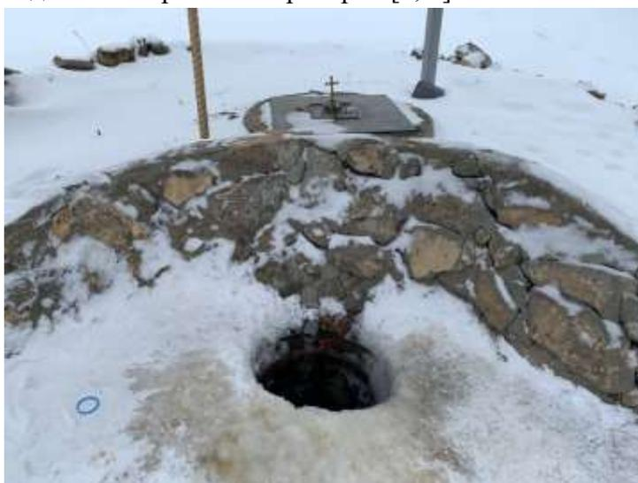
**Рисунок 2. Каптажное устройство и выход воды**
